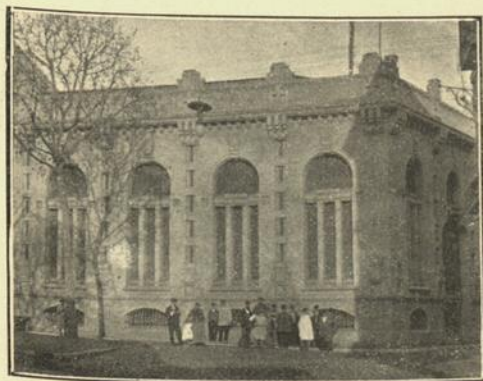
Central de Electricidad para el alumbrado público
