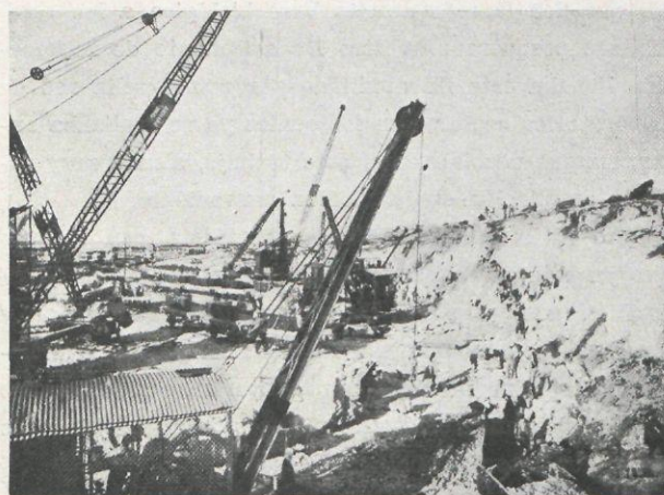
Figura 4.ª—Vista de las canteras. El frente tiene una altura máxima de 12 metros
