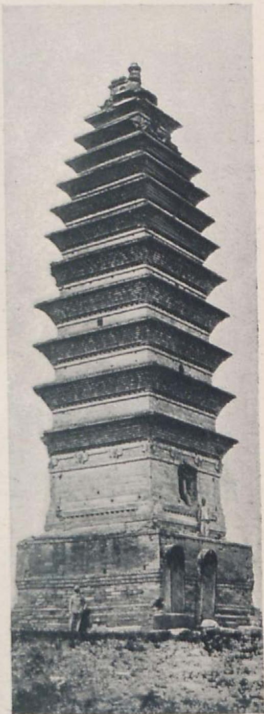
LA PAGODA POMA SZE. CONVENTO DEL CABALLO BLANCO, CERCA DE HONANFU; CONSTA DE 12 PISOS CON TERRAZAS, TIENE UNA ALTURA DE 30 METROS Y FUÉ CONSTRUÍDA EN EL AÑO 1175.
