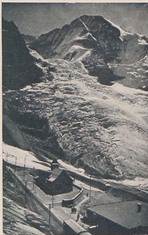
FIGURA 2.*—LA ESTACIÓN DE EIGERGLETSCHER
