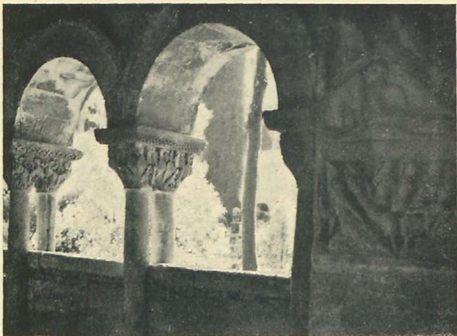
DETALLE DE LA GALERÍA ORIENTAL DEL CLAUSTRO BAJO
