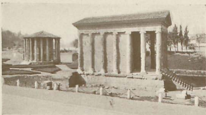
LA NUEVA VÍA ROMA-OSTIA PASA POR ESTE RINCÓN DE LA VIEJA CIUDAD, JUNTO AL TEMPLO DE VESTA.
