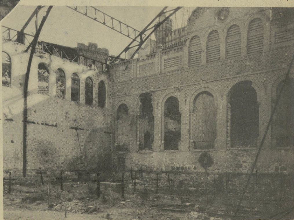
Dans ce qui fut le pavillon du Picadero, on a improvisé, en creusant le sol dur, des tombes pour les victimes des bombardements.
