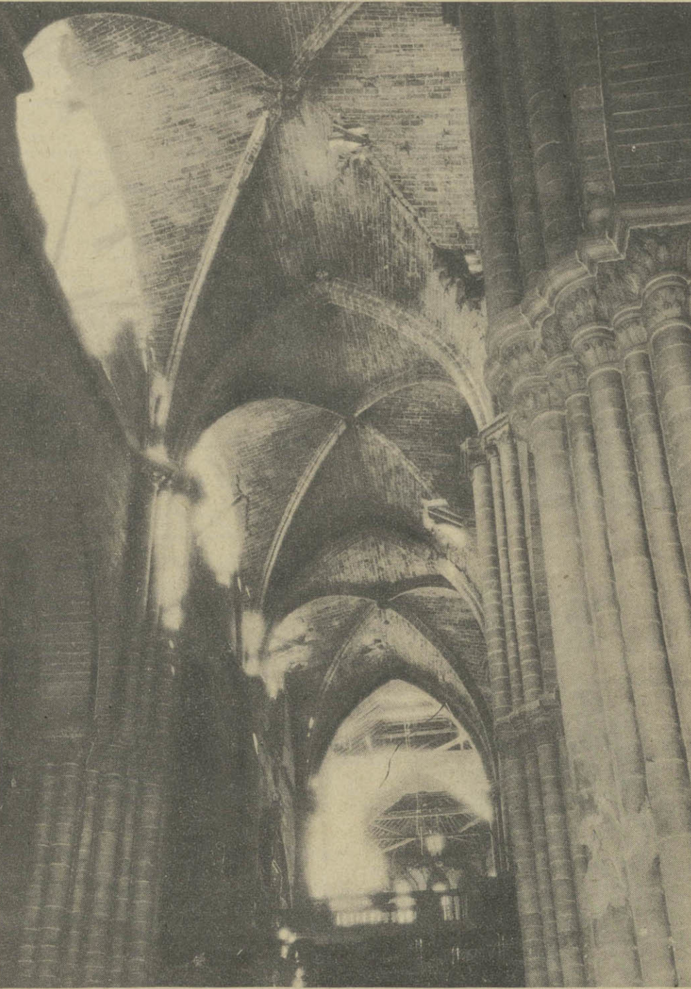
Voûtes à moitié écroulées de la nef centrale de la cathédrale de Sigüenza, qui fut pillée puis détruite par les Rouges.
