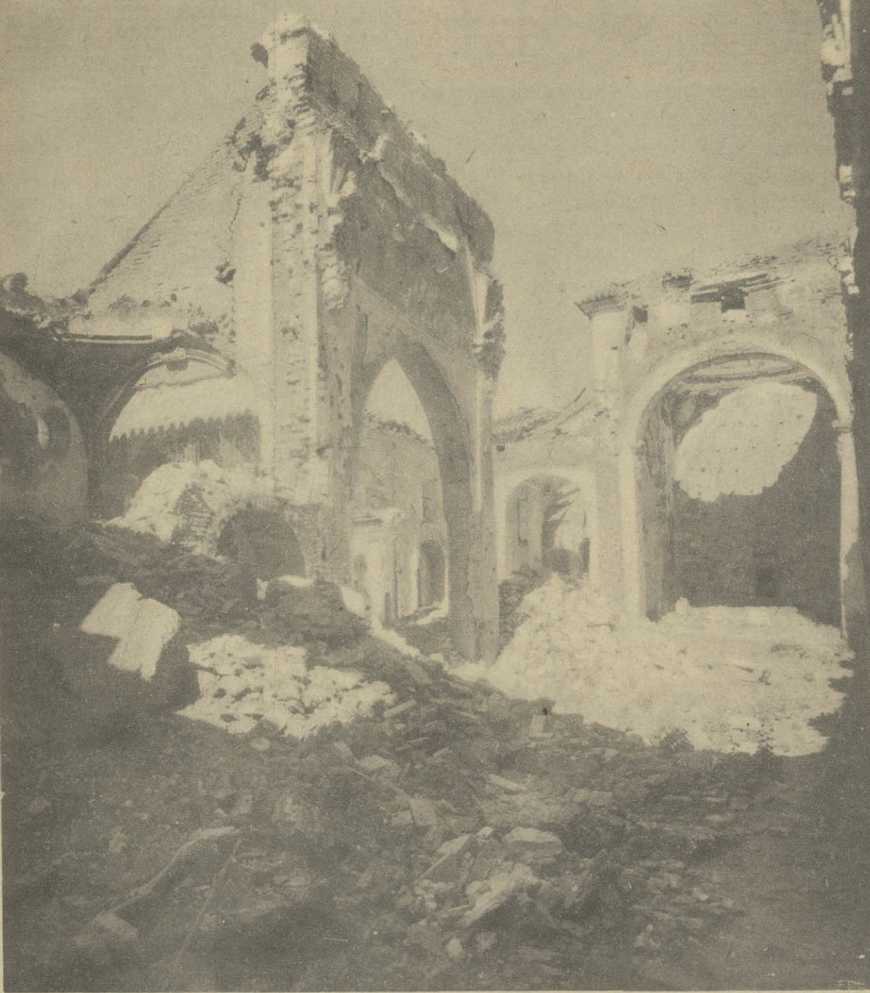
Bujalance (Cordoue). Ruines de l'église de Saint-François, démolie par les Rouges.
