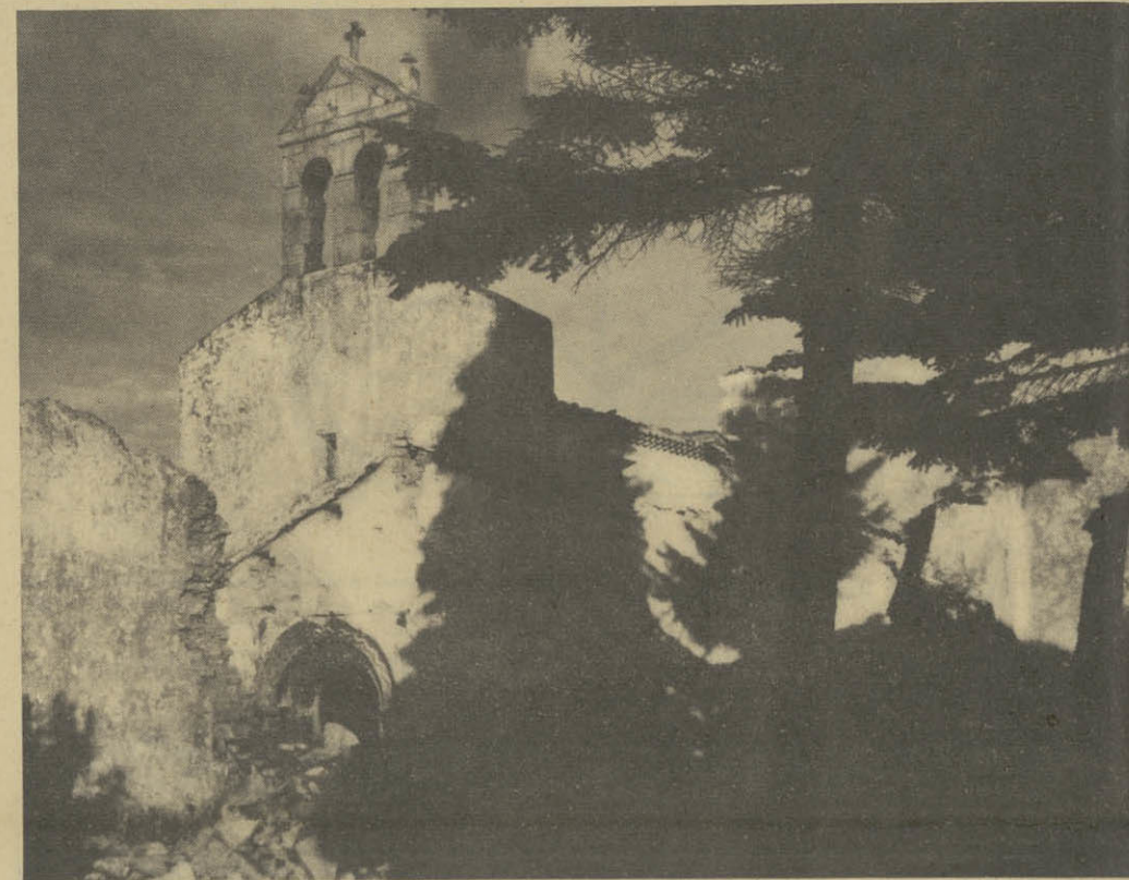
Trasona (Asturies). Façade de l'église Saint-Vincent incendiée.
