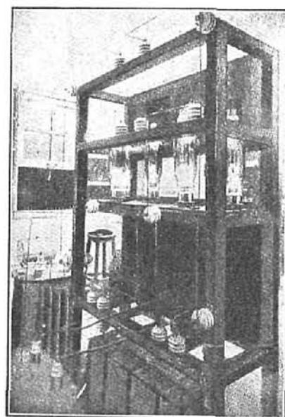
Transformador, reactancia y condensadores del equipo rectificador filtro.
