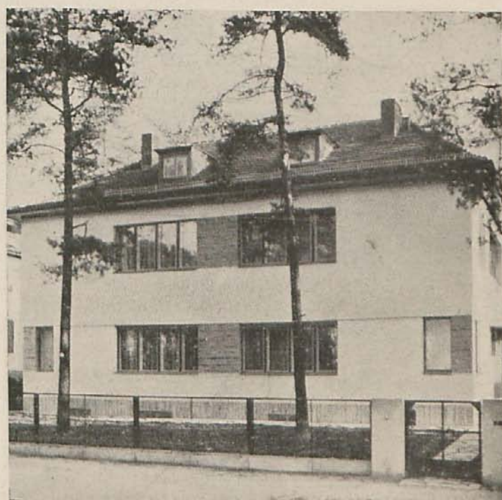
Fachada a la calle.
