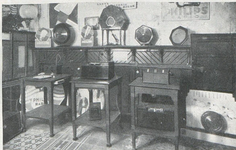
Sala de audiciones de la casa Valero (Alicante).
