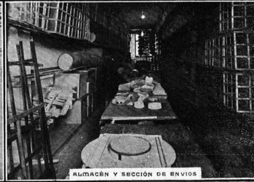
ALMACÉN Y SECCION DE ENVÍOS
