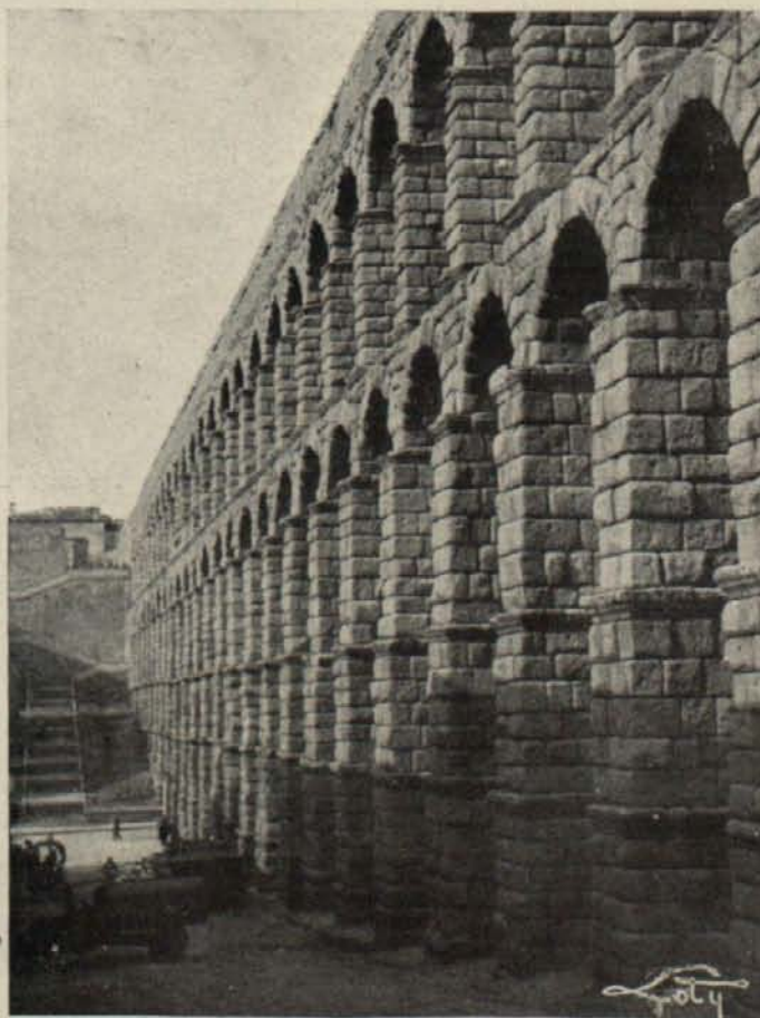
Vista general del Acueducto
