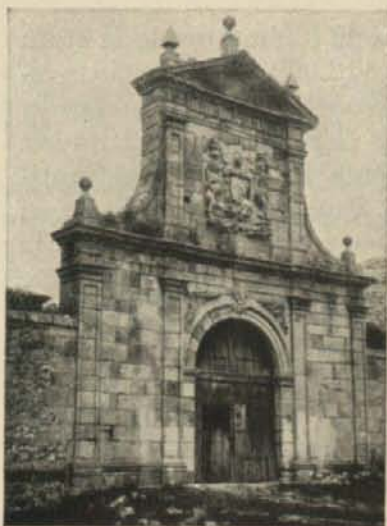
Portalada en Puente Arce
