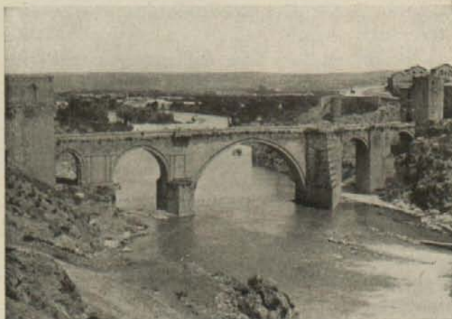
Vista general del puente.
