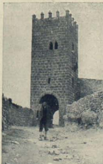
Torre del Homenaje, en el monasterio de Piedra
