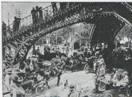
Aspecto de la Pasarela
