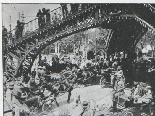
Aspecto de la Pasarela
