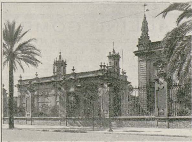
Edificio lateral construido para cárcel
