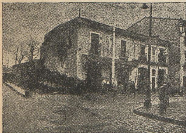
Otra vista del mismo mercado incendiado.
