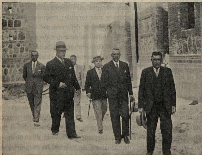
El Director general de Prisiones, Sr. Sol, recorriendo las obras de la nueva prisión de Málaga en unión de los Sres. Montoto, Agustí, Maroto, Sáinz de Vicuña y Cevallos.
