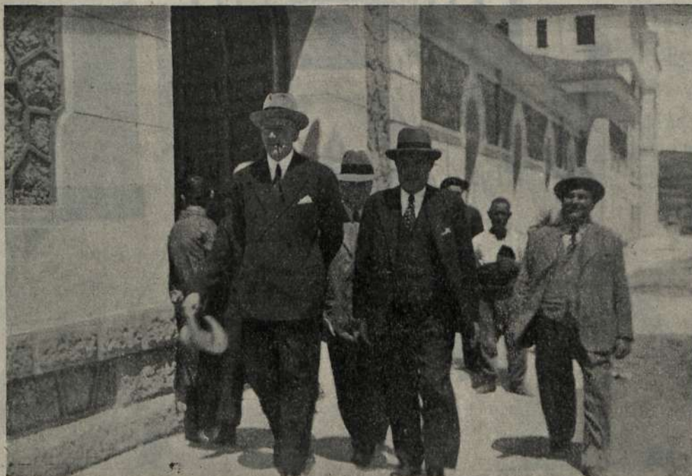
El Director general de Prisiones con el Arquitecto de la Dirección Sr. Agustí y el Contratista D. Severiano Montoto, visitando las obras del nuevo penal de Burgos.
