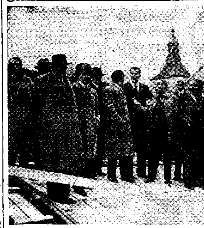
LA CONSTRUCCION DEL NUEVO VIADUCTO.—Ayer tarde visitaron los ingenieros de Caminos Sres. Aldas y Aracil las obras del nuevo Viaducto. En las fotografías, los mencionados ingenieros explican a sus acompañantes las características de su proyecto (Fotos Alfonso.)
