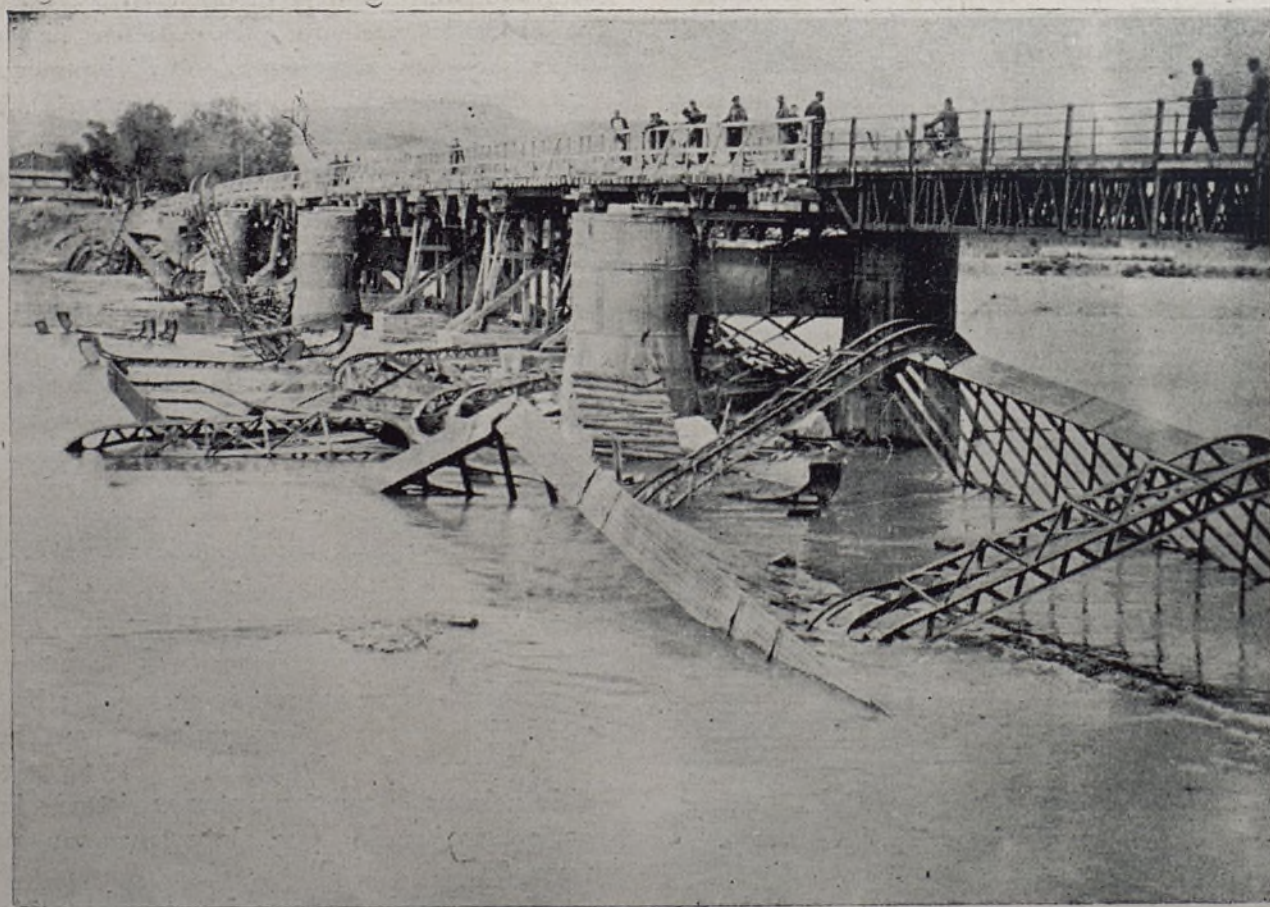
FRENTE DE ARAGON.—Nuevo puente sobre el Cinca edificado sobre las ruinas del volado.
