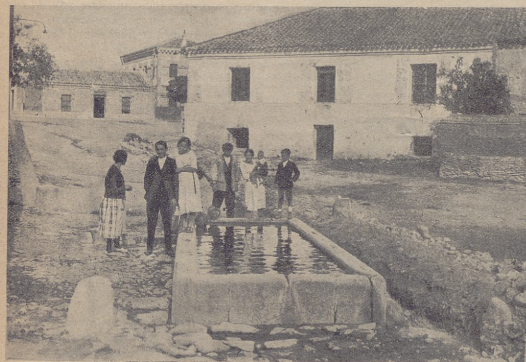
La fuente, tal y cómo fué construída, tampoco se transforma en lavadero.
