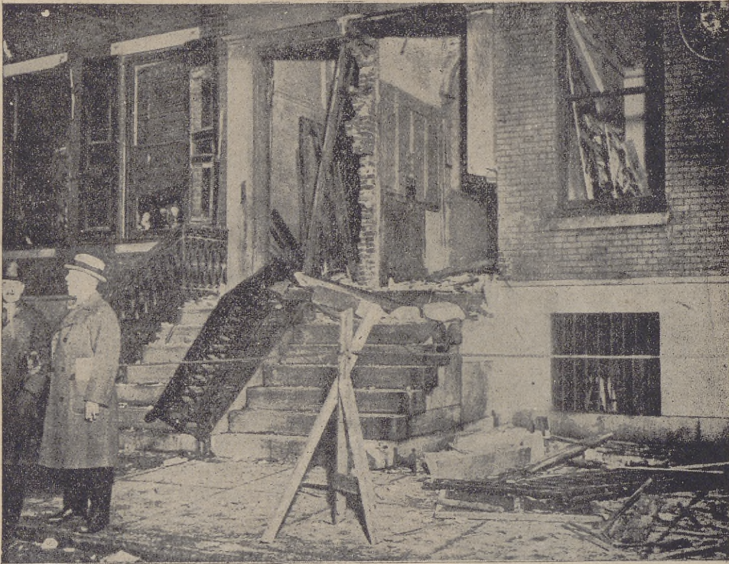
En el Consulado español de Filadelfia estalló una bomba recientemente produciendo enormes destrozos materiales.
