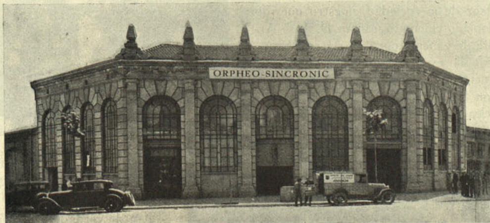
Fachada de los talleres
