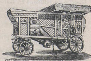
TRILLADORA Á VAPOR
