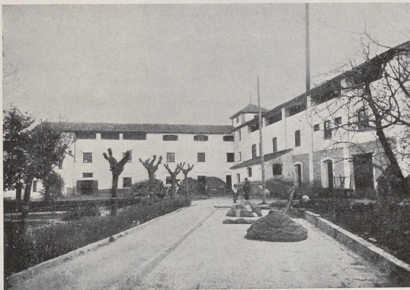
Vista parcial del exterior de la fábrica.
