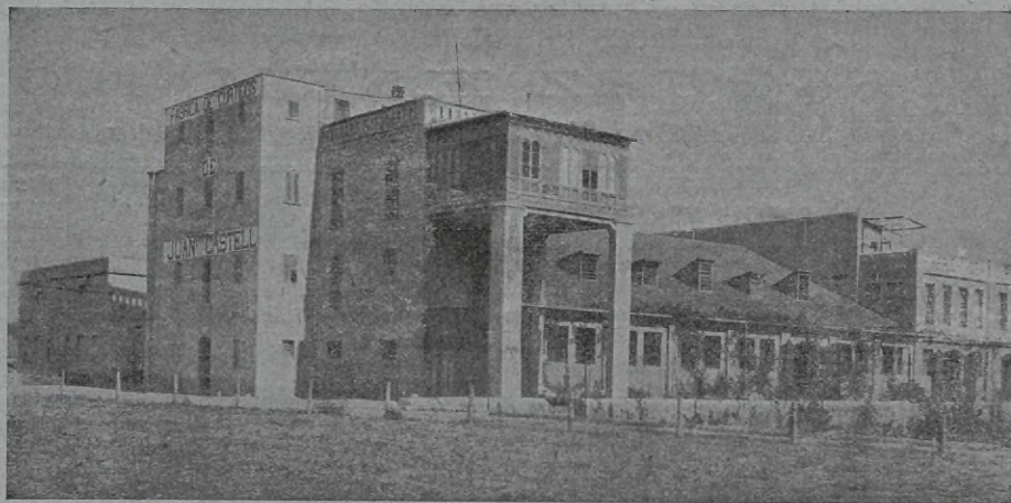
Vista exterior de la fábrica.
