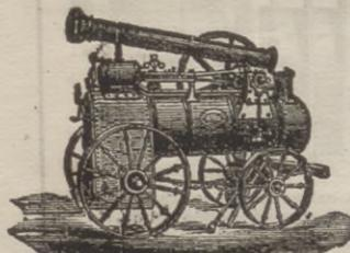
Máquinas de vapor portatiles para toda clase de combustible.
