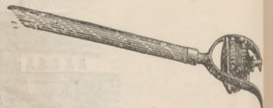
No. 10.—Lámpara inquebrable para Minera, Plata, etc. Esta lámpara puede espesarse sea con quemador para aceites pesados ó con quemador para Kerosina ó Petroleo, pero con éste último aceite el quemador espide luz. Se recomienda especificar cual de los quemadores se desea al hacer el pedido. Precio, cable de freno y horquillas del mejor hierro maleable, completa...35s por doc. Se abastecen sin cables si se desea, á precios mas baratos.
