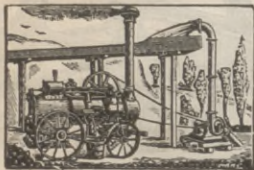
Bombas de vapor.
