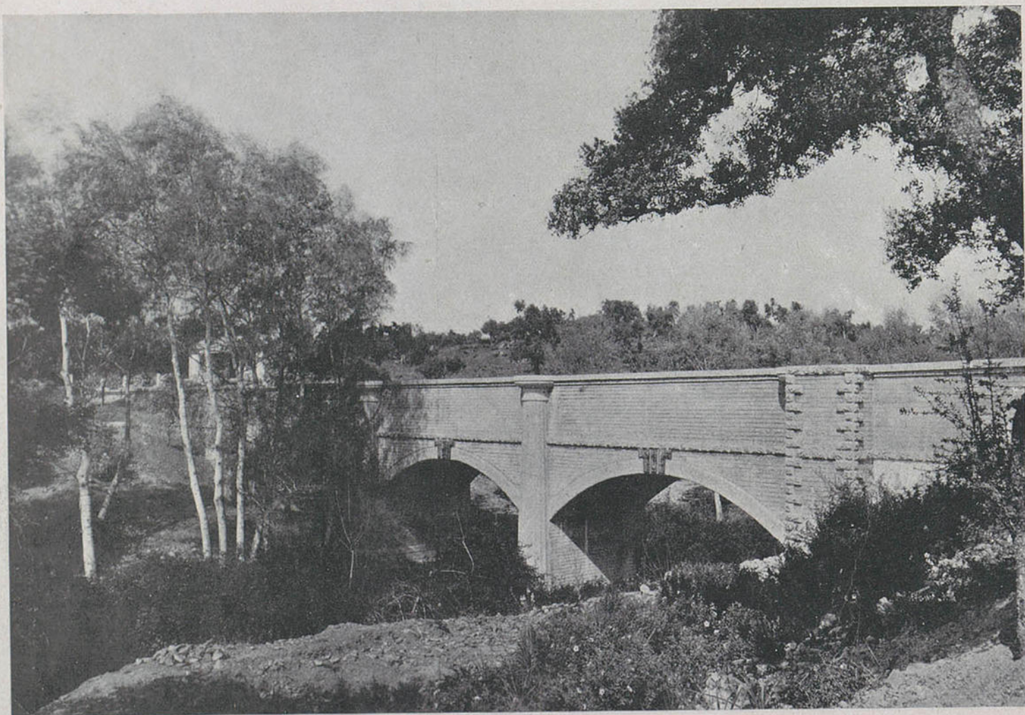
Acueducto del Arroyo de Rabanales.
