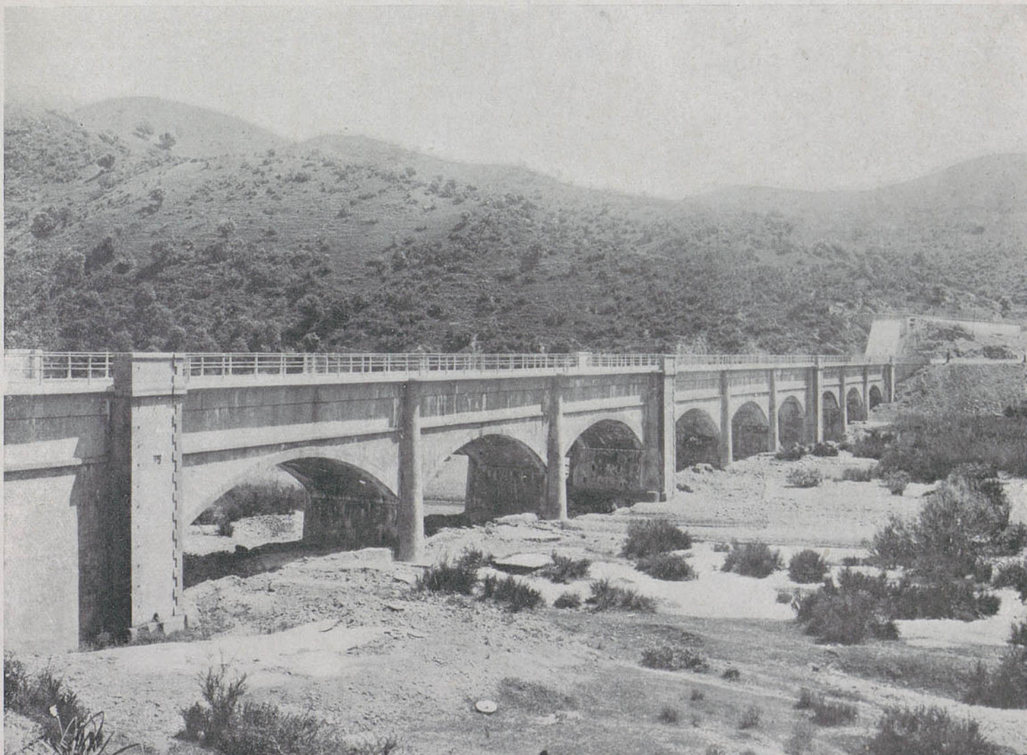
Sifón doble de dos metros de diámetro en hormigón armado.
