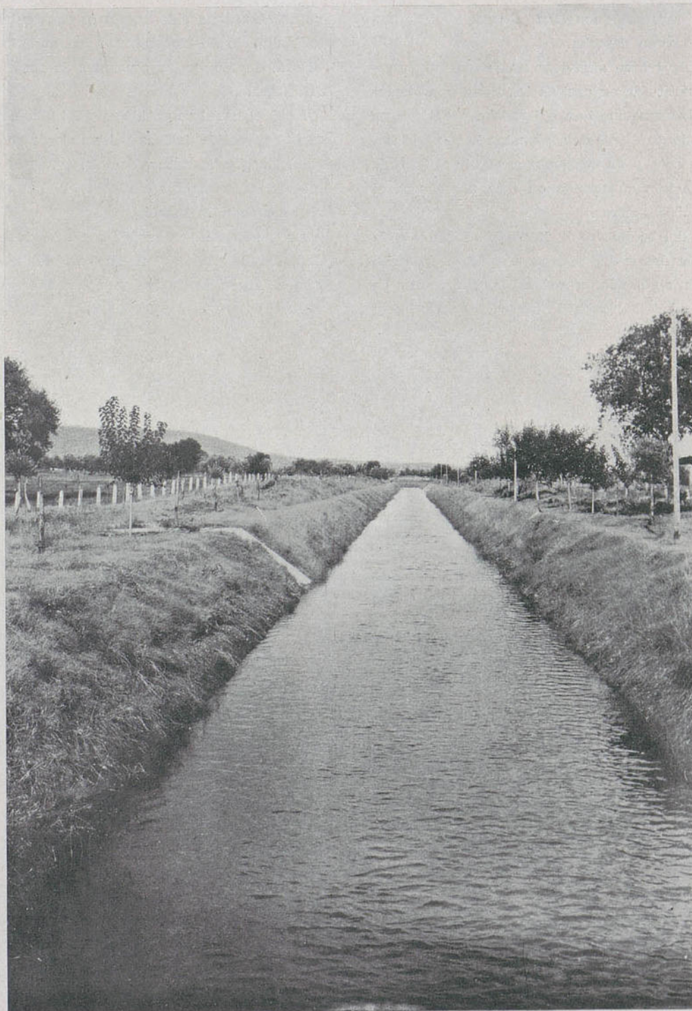
Canal en tierra con solera revestida.
