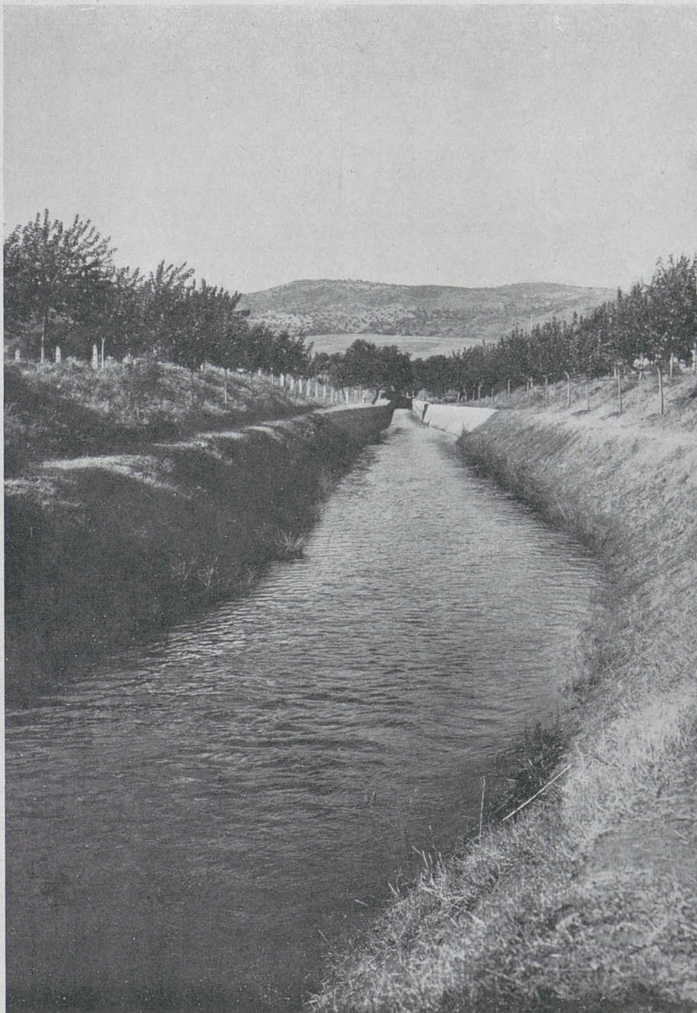
Canal en tierra con cambio a sección revestida.
