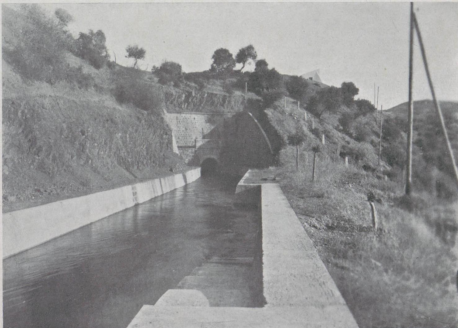
Entrada al túnel bajo la carretera.
