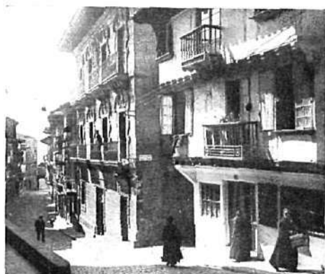
CALLE PRINCIPAL DE FUENTERRABÍA Cliché obtenido con el Heróspido Gaumont.
