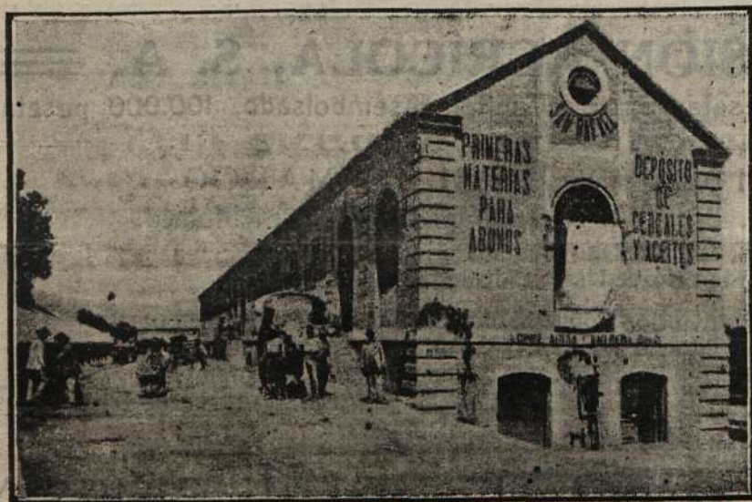
Vista del almacén de Pinos Puente
