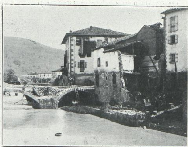
ELIZONDO.—Casa y puente destruidos por la corriente
