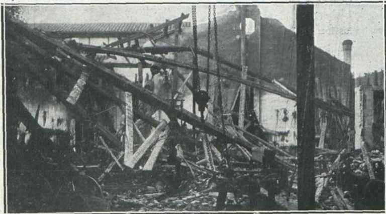
SANS (BARCELONA).—Incendio de los talleres de maquinaria de D. Ramón Puig y Negre.—(Fotog. B. y C.)
