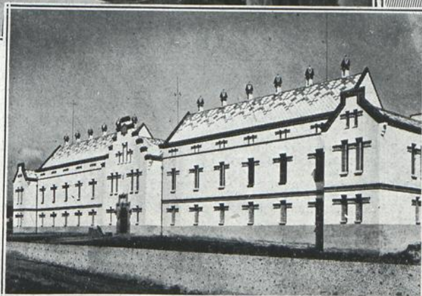
Fachada principal del nuevo Hospital (Fotog. E. Coll)
