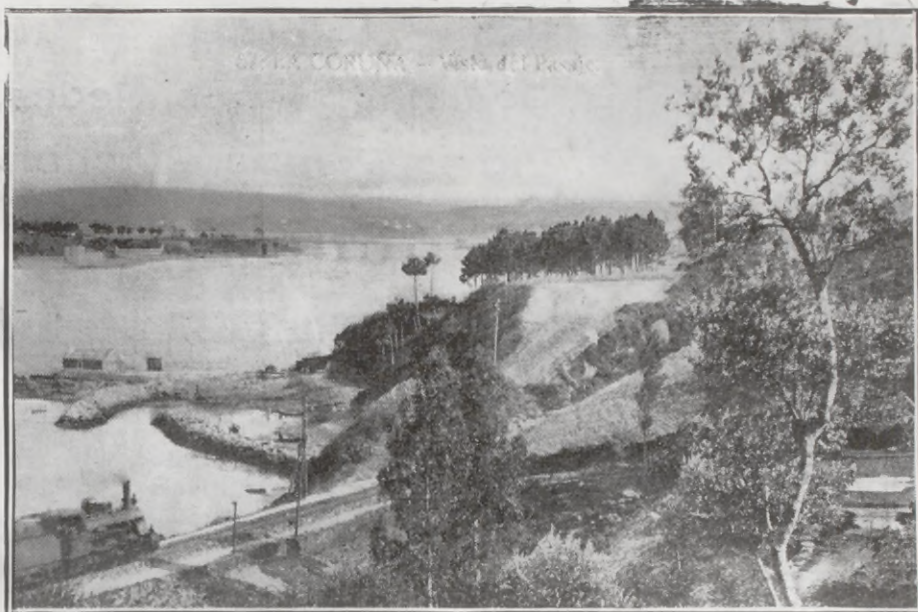
La Coruña.—Vista del Pasaje
