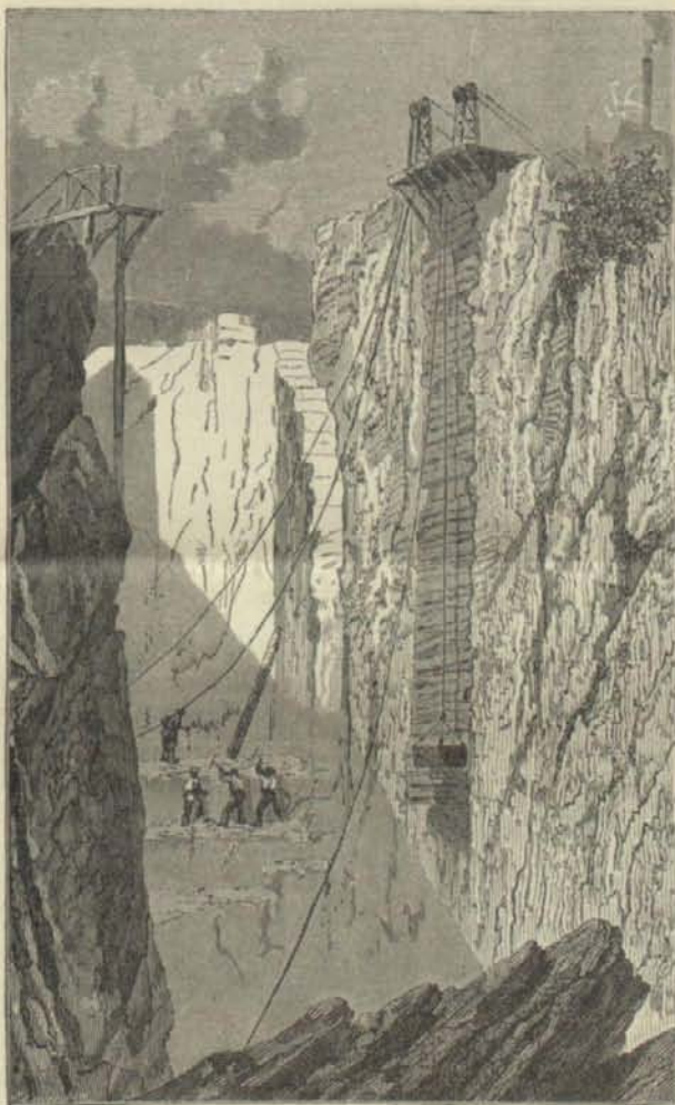
Corte de terrenos en la explotación de una cantera.
