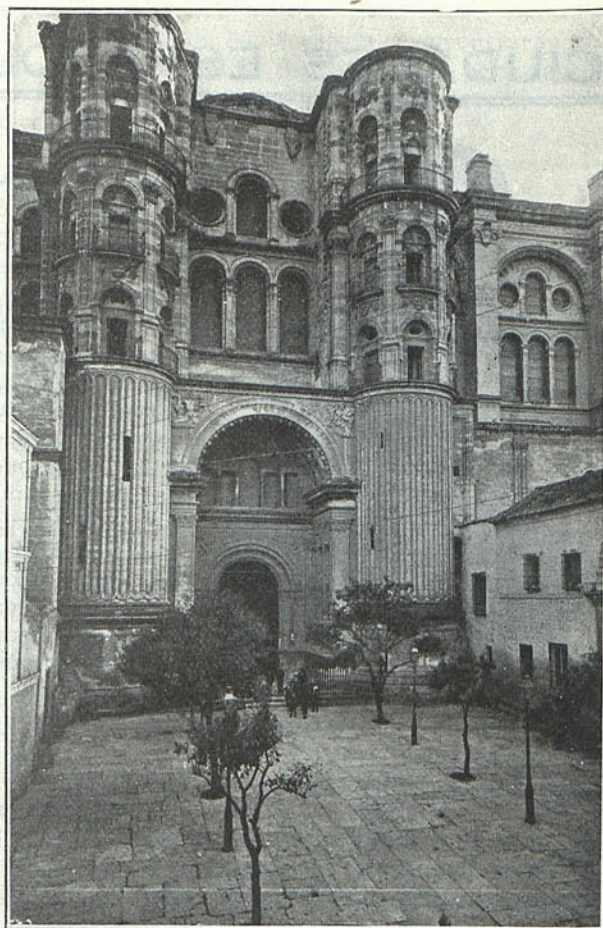
MALAGA.—Fachada de la Catedral.
