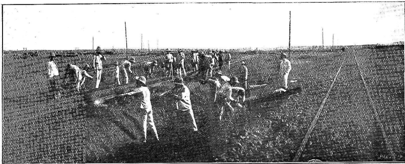
Tendido de la via férrea desde la segunda caseta á Nador.
