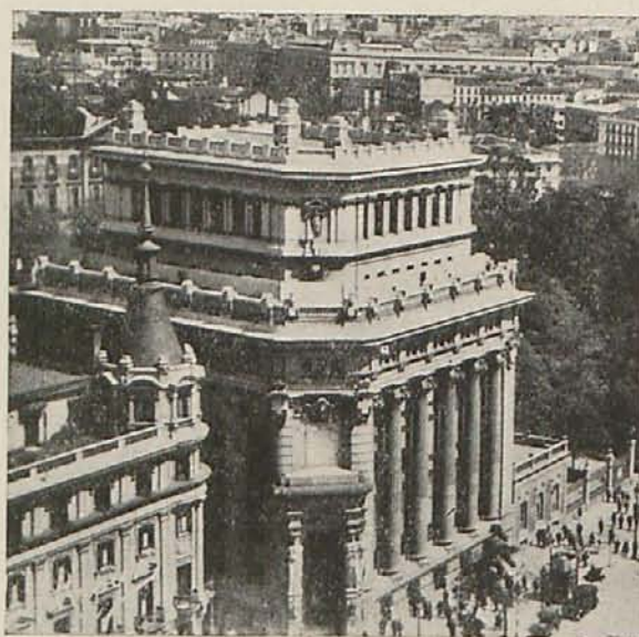
Edificio del Banco Central.
