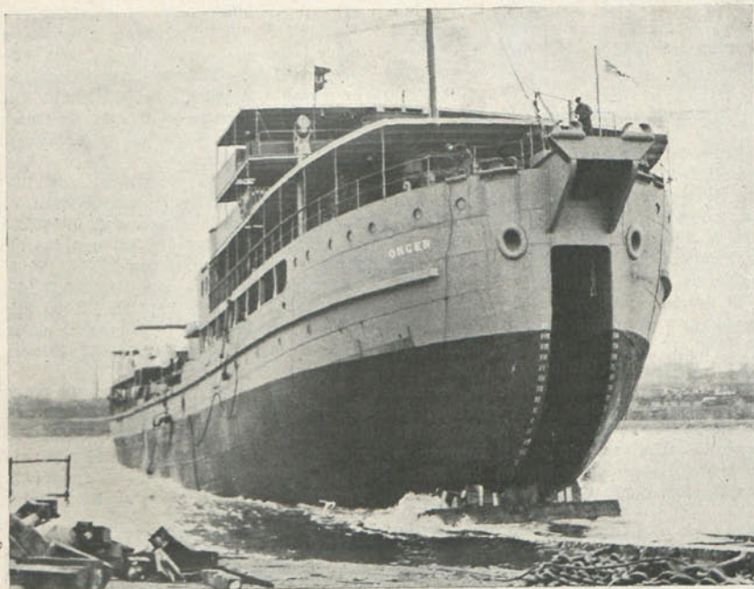
Botadura de la draga "Onger", en los astilleros de W. Simons & Co. Ltd., de Renfrew, para su empleo en el puerto colonial británico de Basrah. La botadura se ha efectuado con la draga completamente terminada, lista para salir a su destino.
