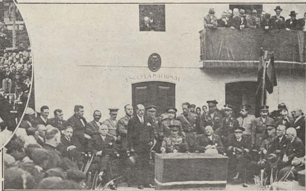
PREMIÁ DE MAR.—Inauguración del abastecimiento de agua potable, que se celebró el pasado domingo en Premiá de Mar, con asistencia de las primeras Autoridades de la Provincia.
