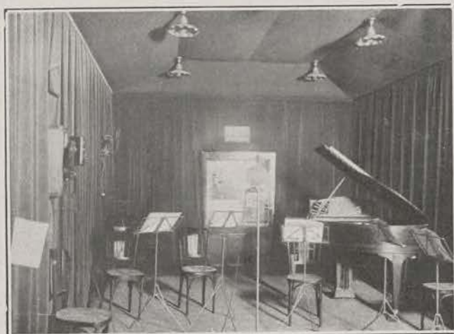
Estudio de conciertos. (Edificio Avenida Libertad.)
