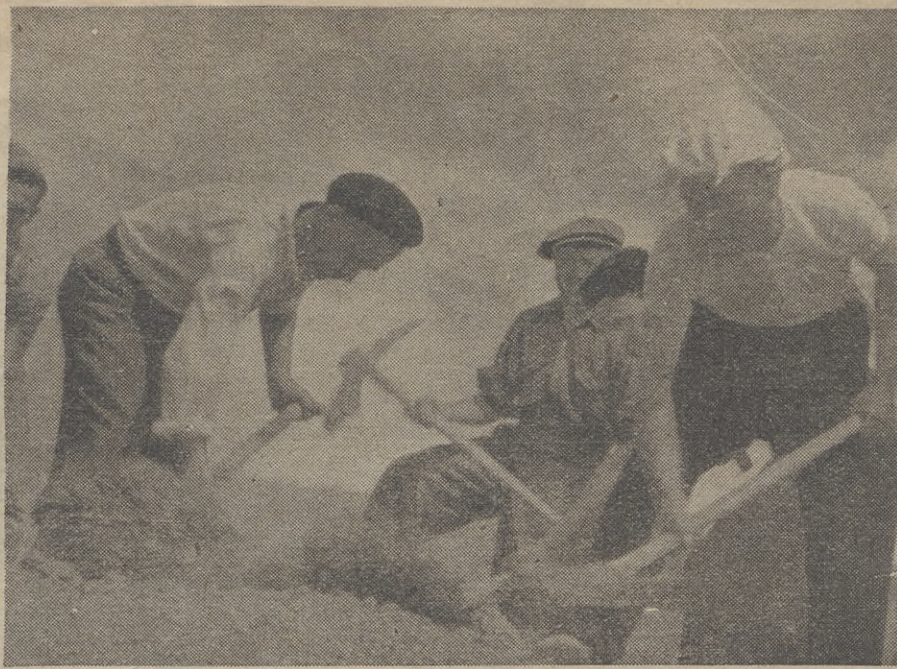
Un aspecto de los trabajadores de retaguardia en plena tarea, construyendo el nuevo ferrocarril
