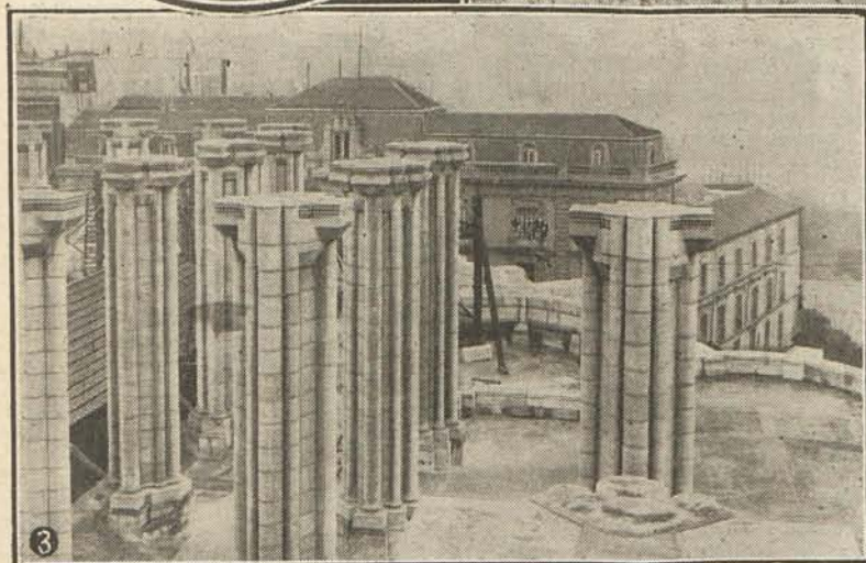
Estado actual de las obras.
