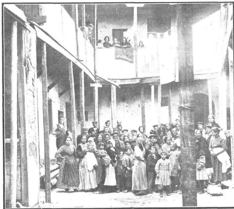
MADRID. PATIO DE LA CASA DE LA PLAZA DE LAS PEÑUELAS QUE AMENAZA INMINENTE RUINA Fot. Cifuentes
