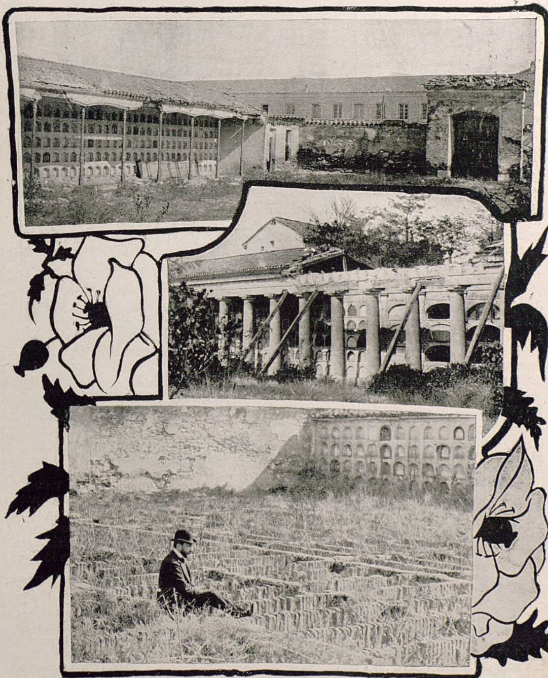
1.º Cementerio general, Iglesias ruinosas. 2.º Cementerio de San José y San Luis. Ruinas de las galerías principales. 3.º Galerías y fosas hundidas del Cementerio general del Norte.—(Fot. Terol).
